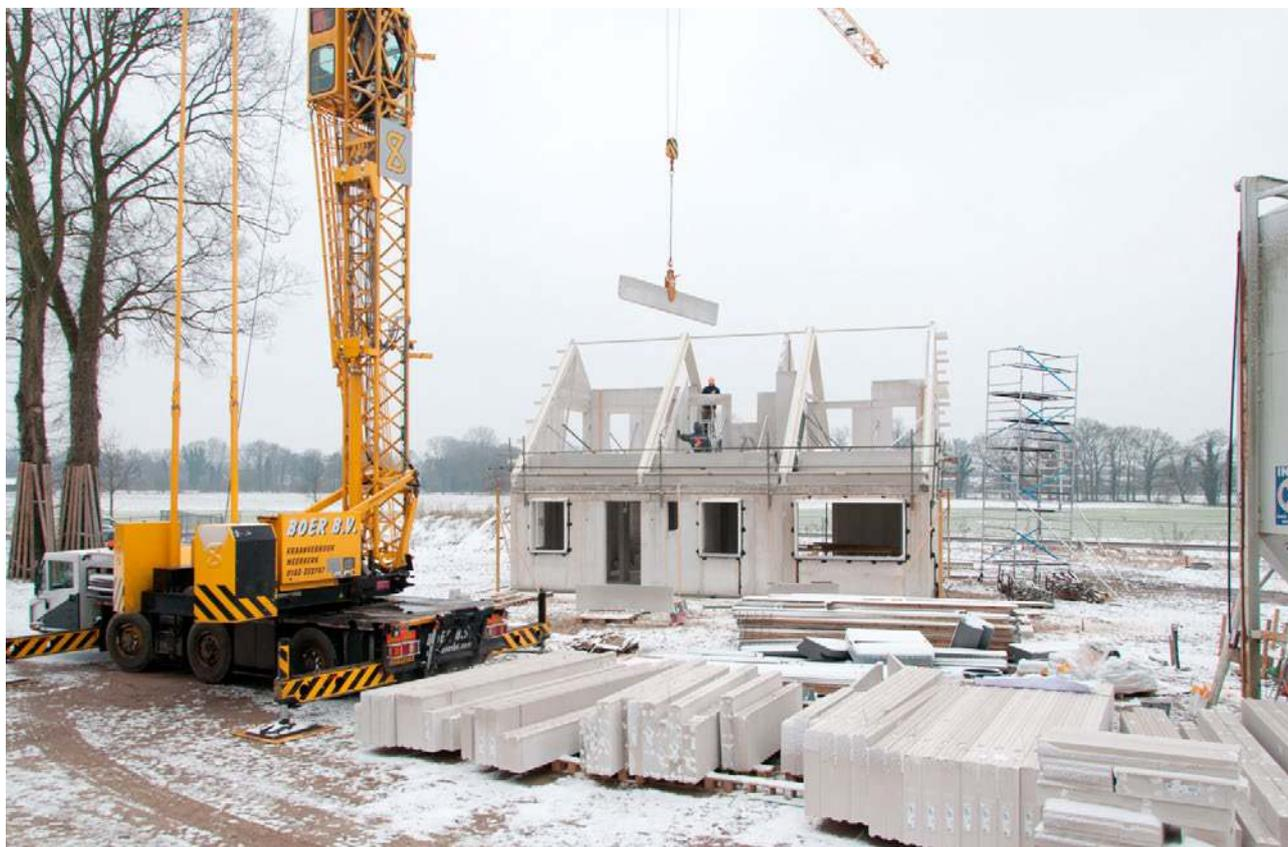
**Рис. 1. Строительная площадка с использованием панелей и перемычек из автоклавного газобетона для строительства жилого дома (Нидерланды)**
